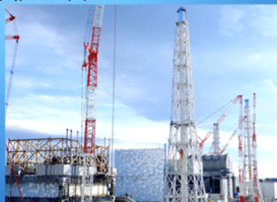
1F1号機側からの外観(東京電力ホールディングス提供)
