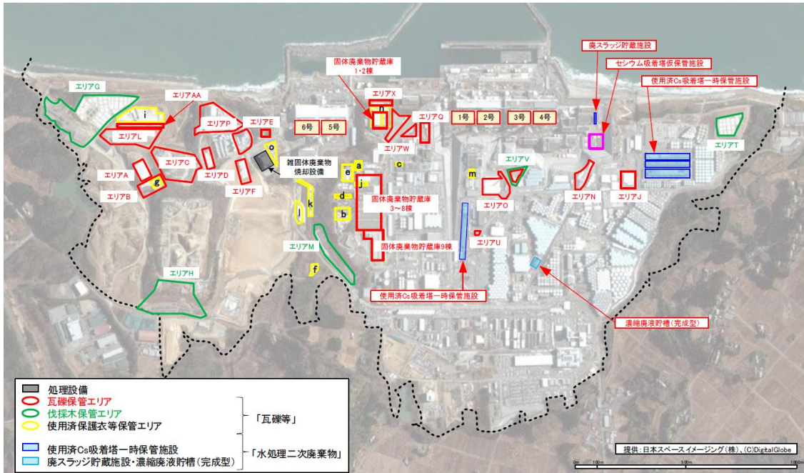
(a) 「ガレキ等」及び「水処理二次廃棄物」の保管状況
