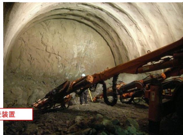
廃棄物埋設地相当の坑道
