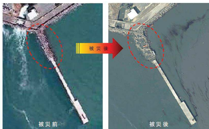
外港地区 北防波堤 (平成23年2月16日、3月12日撮影⑦) 消波ブロック飛散(100m)
