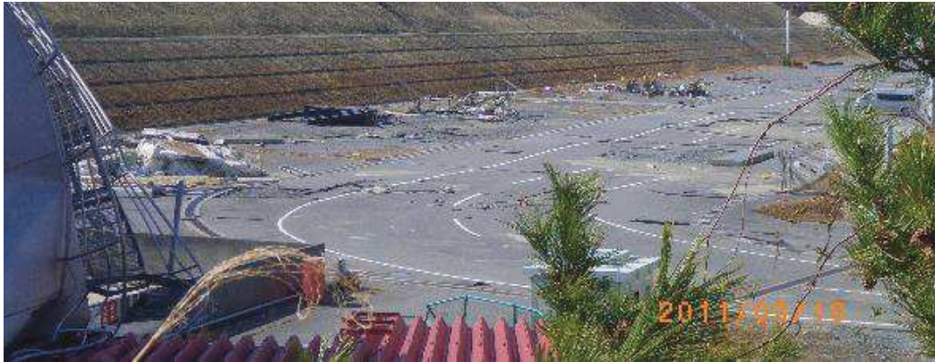
写真 4. 2-1(2) 敷地内で確認された東北地方太平洋沖地震に伴う津波の漂流物 (岸壁全体の漂流物状況 (平成 23 年 3 月 18 日撮影))
