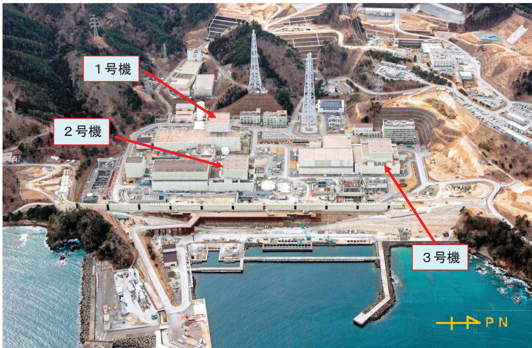
図 2-2 女川原子力発電所の全景
