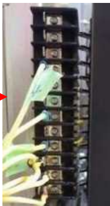
(1) 制御回路断路部（台車のロッキング応答 ⇒ 端子の変形）
