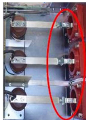
(インターロックピンの脱落による台車の飛び出し ⇒ 引き抜け) (機能喪失前) (機能喪失後)
