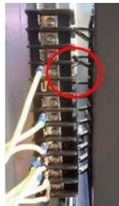
(1) 制御回路断路部（台車のロッキング応答 ⇒ 端子の変形）
