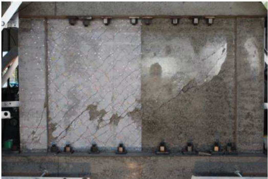
図 3-2 試験体 S-13-D0 最終破壊時写真
