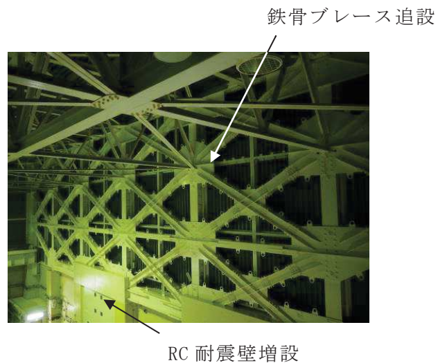
図 1-2 耐震補強工事状況写真
