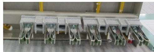
ユニットの差込み接続箇所 (裏面)
