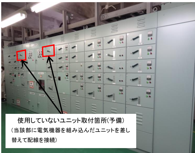
廃溶媒処理技術開発施設の換気・プロセス用動力分電盤
