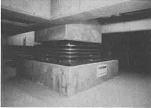
図3 水平変形制限装置 2)
