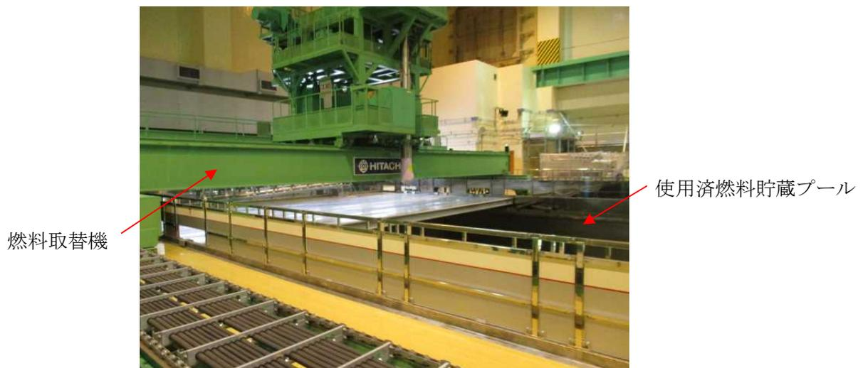
現場調査時、使用済燃料貯蔵プールの直上に耐震Bクラスの燃料取替機が待機しており、地震時に落下する可能性があるものとして抽出された。現状は、使用済燃料貯蔵プールへの重量物落下防止の観点から、燃料取替機は使用済燃料貯蔵プール上に待機配置は行わないこととしているが、使用時には使用済燃料貯蔵プール上に位置することから、基準地震動 $S_s$ による評価を実施する。
