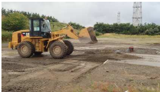
段差復旧状況③
