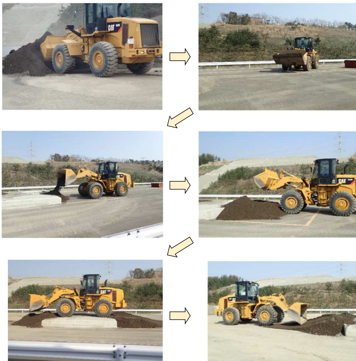
図 12-8 約 50cm の段差の仮復旧 (3)
