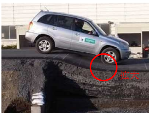
図9-12 不等沈下後における路面状況
