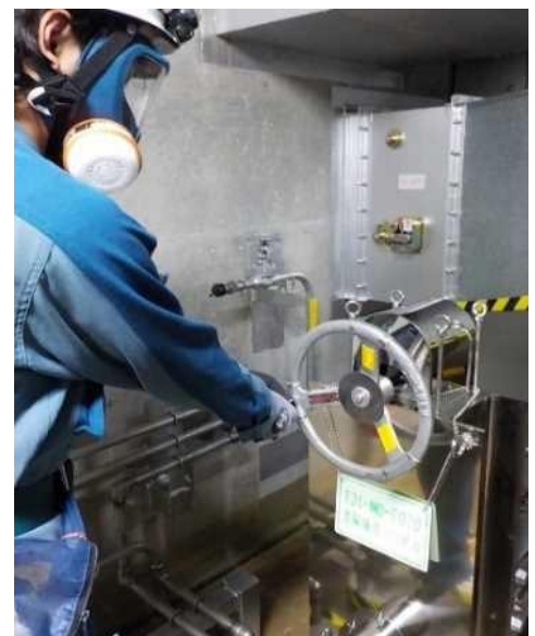
格納容器ベント操作
