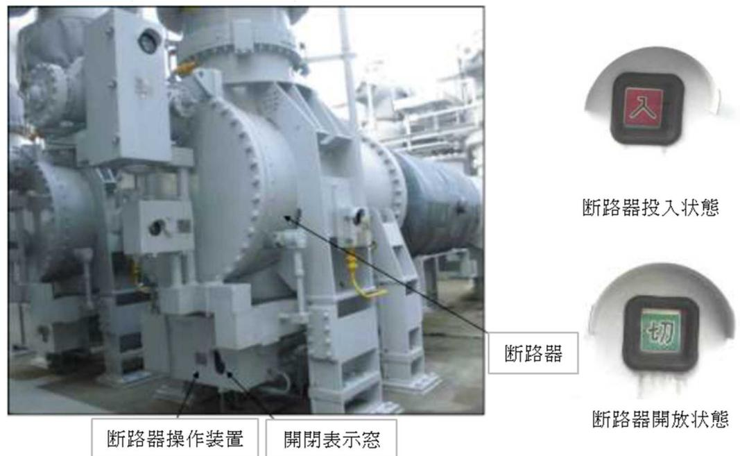
図1-25 断路器外観（開閉状態確認イメージ）
