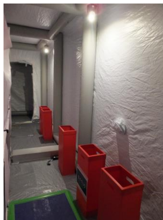
図 1.1-13 乾電池内蔵型照明（ランタンタイプ）確認状況
