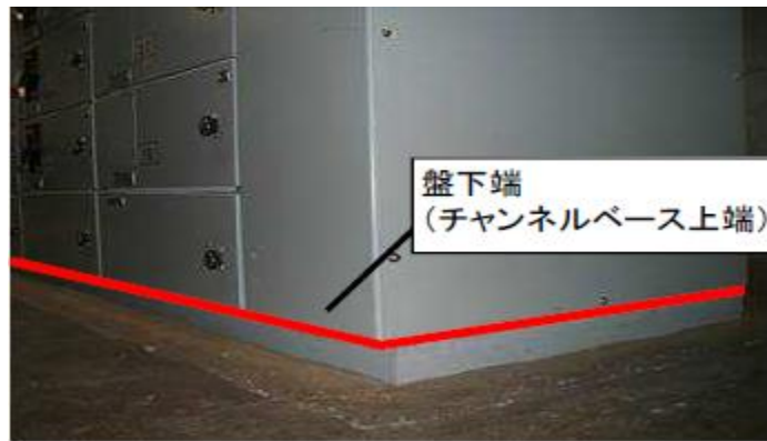
第 1.1-4 図 機能喪失高さ（盤の例）
