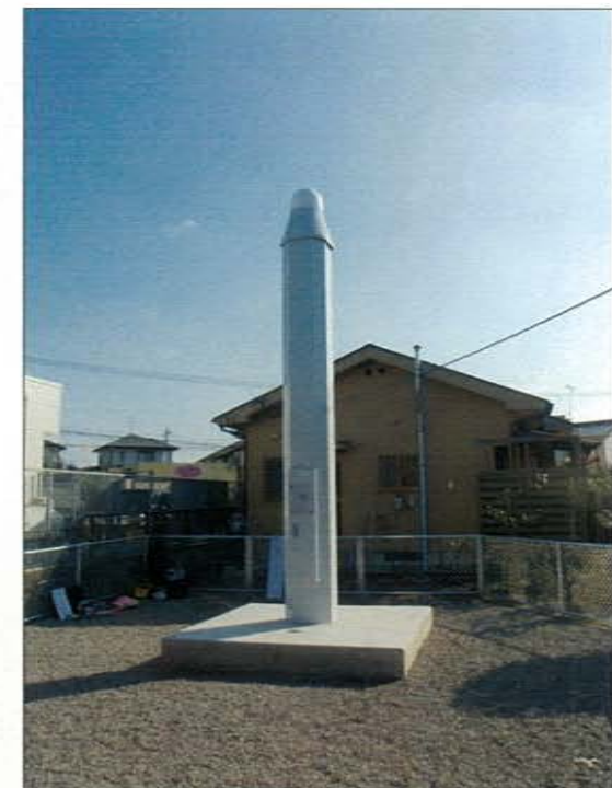
吉野町の機器設置状況
