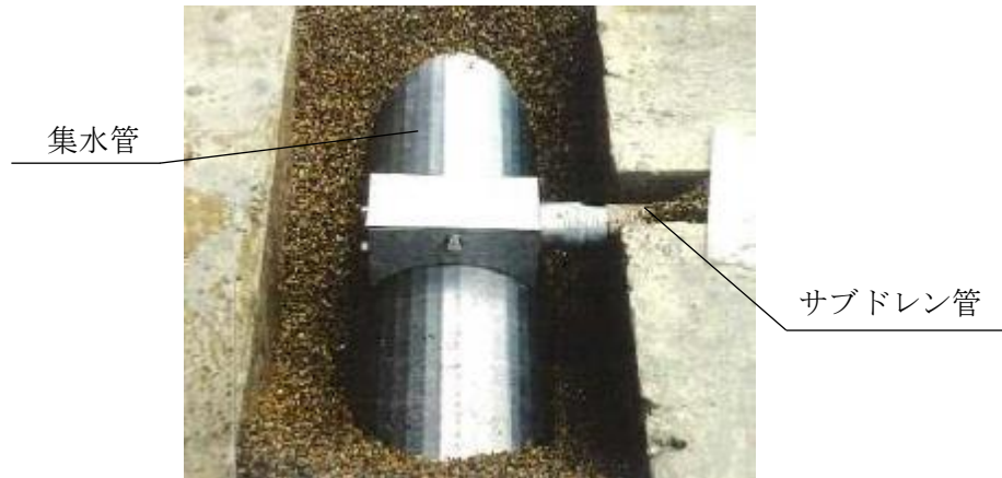
第 3-15 図 集水管敷設状況
