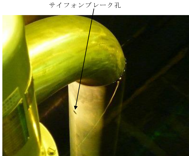
図 1-2 サイフオンブレイク孔の現場写真
