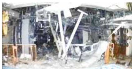
写真① (3階開口部から北向き)
