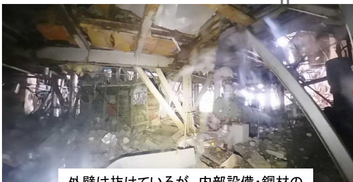
外壁は抜けているが、内部設備・鋼材の大規模な損傷は見られない
