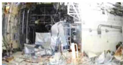
写真③ (2階開口部から北向き)
