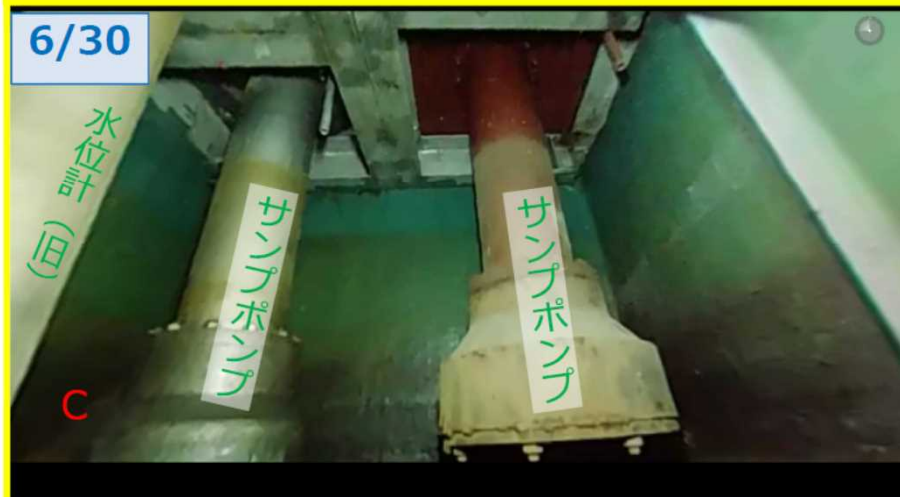
1/2号機排気筒ドレンサンプピット内部調査状況 (2020年7月20日 東京電力HD株式会社)より抜粋
