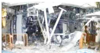
写真① (3階開口部から北向き)
