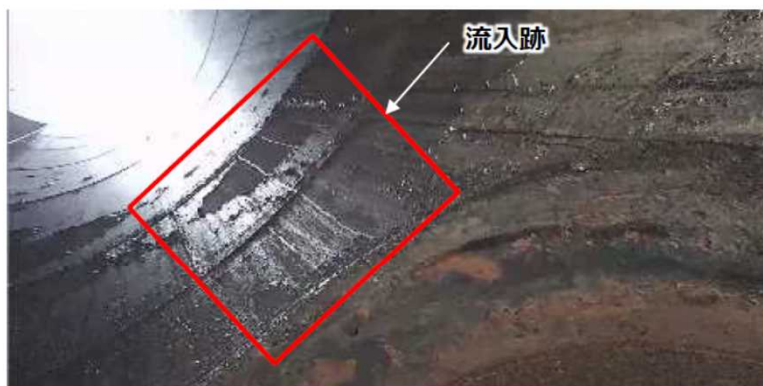
写真：排気筒内面状況（5/20雨天時）
