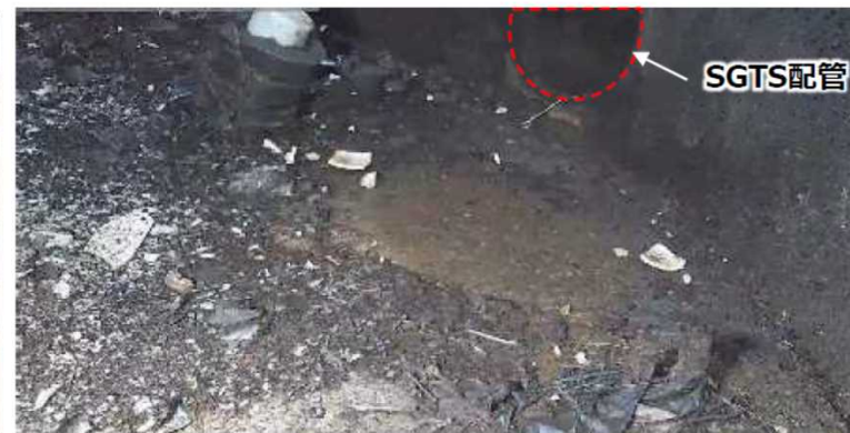
写真：SGTS配管状況（5/20雨天時）
