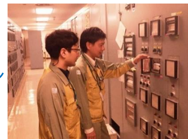
ペアパトロールの様子
