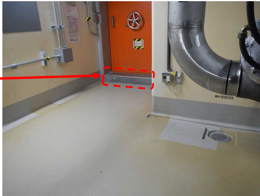
図 4 - 1 漏えい油の拡大の防止対策の例
