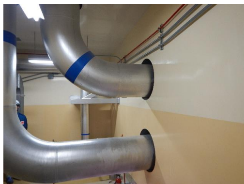
図3 貫通孔の隙間の例
