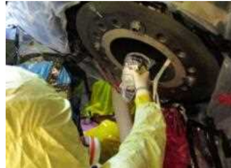
マンホール表面
