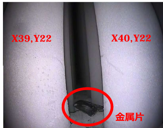
4号機 22回定期検査 金属片
