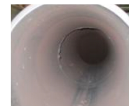
SGBDタンク行配管
