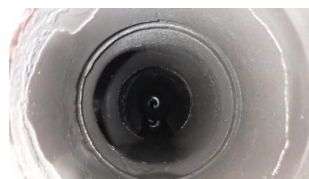
④流量制限オリフィス (A-SGの例)
