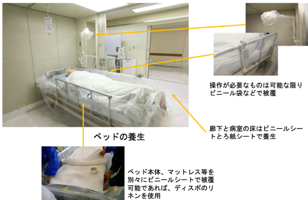
図4 病室の養生（例）
