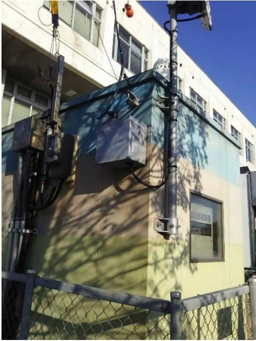
図3 局舎屋根上部に設置されている局
