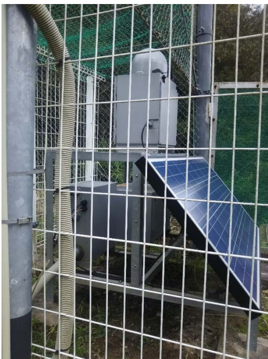
図8 鹿児島県における半導体式線量計の設置例 ソーラーパネルが配置されている
