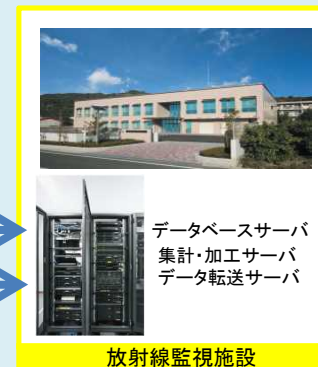
放射線監視施設
