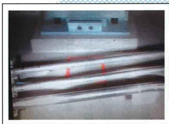
確認ポイントに赤マーキング実施
