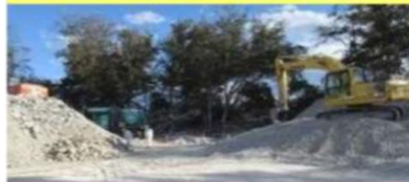
再利用:コンクリートガラ破砕(エリアC)
