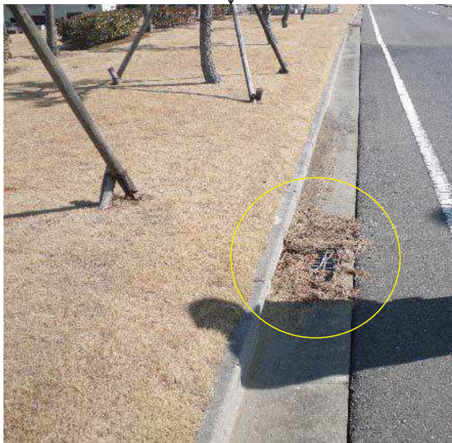
写真2 構内道路上に残留した塵芥
