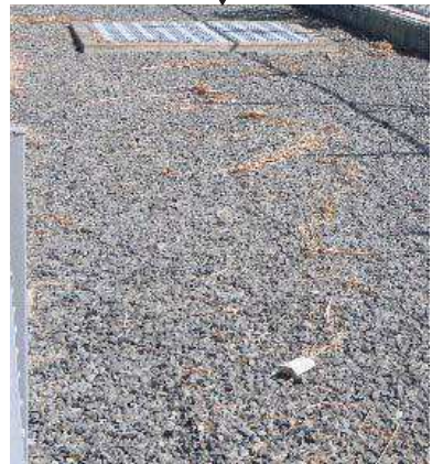
写真1 敷砂利上に残留した塵芥
