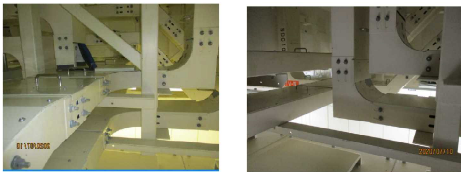
図3. 下部中央制御室の蓋付ケーブルトレイ
