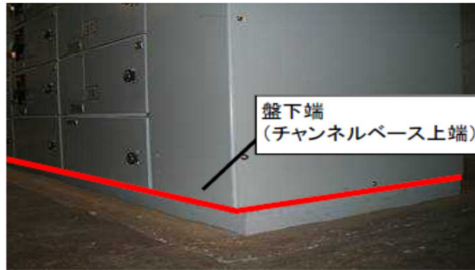
第 1.1-4 図 機能喪失高さ（盤の例）
