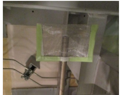
(フラッシングの様子)
