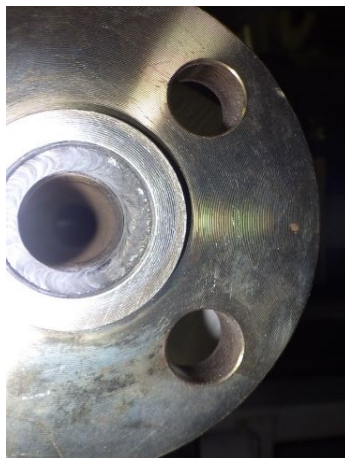
①入口配管
