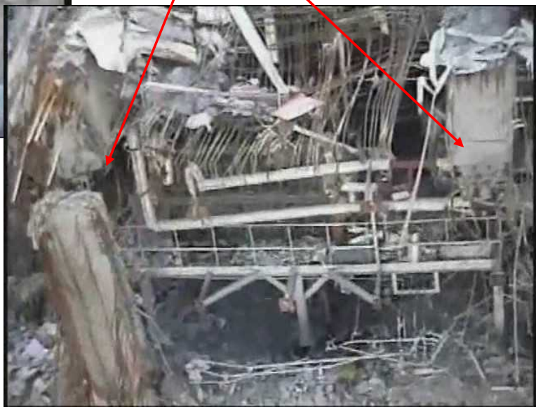
北西部の柱、壁、床が全壊。
