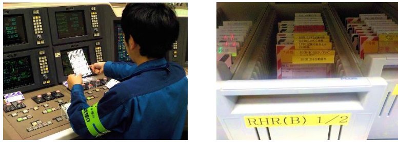
図2-29 中央制御室におけるタグ札運用
