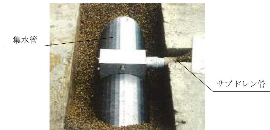
第 3-15 図 集水管敷設状況
