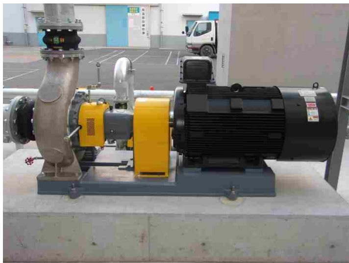
図 3.1.4.3-41 冷却スプレイ用ポンプ
