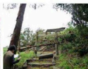
樹木の折損と鳥居の被害
