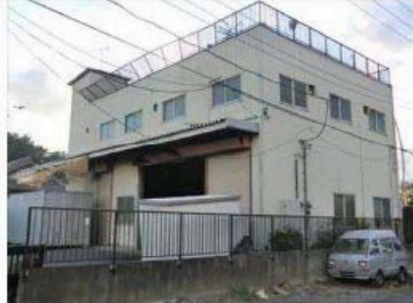
屋上フェンスの変形
