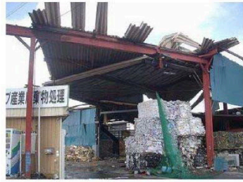
折板の損傷
