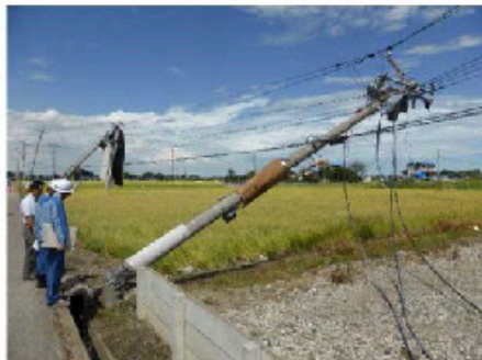
電柱の倒壊
