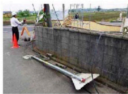
道路標識の倒壊
