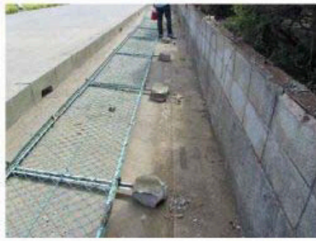
フェンスの倒壊
