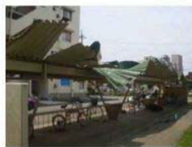
駐車場の折板屋根の著しい変形
