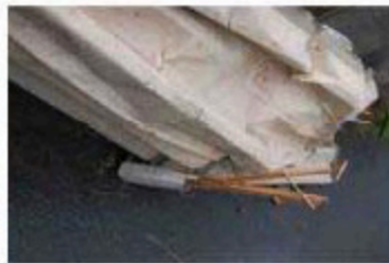
飛散した折板屋根の損傷状況
