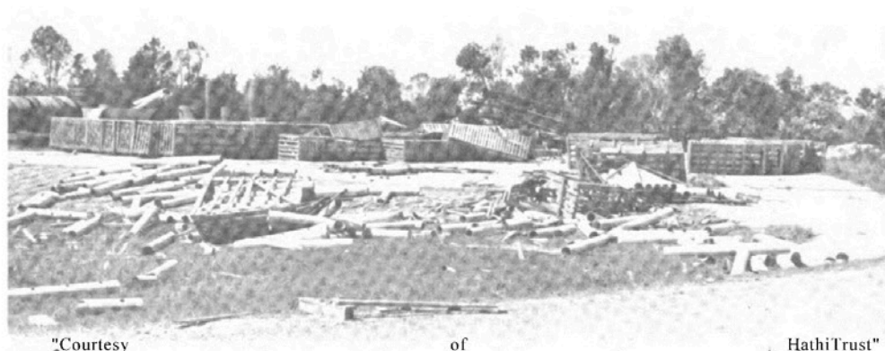
図3.2-1 Grand Gulf原子力発電所の資材置場におけるパイプの飛散状況 (2)
