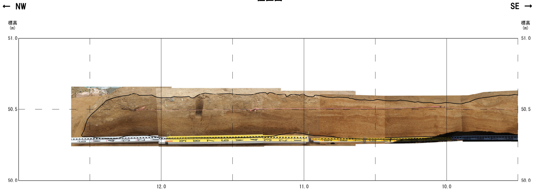
開削調査箇所(南側)側溝設置跡(山側壁面) 写真(範囲A)
