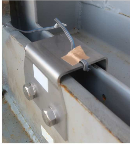
図 2-1 クリップの固定状態及び脱落状態
