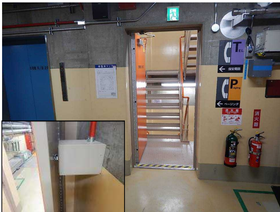
第 9.10-9 図 対策実施予定箇所 の例示 (落下防止板の撤去)
