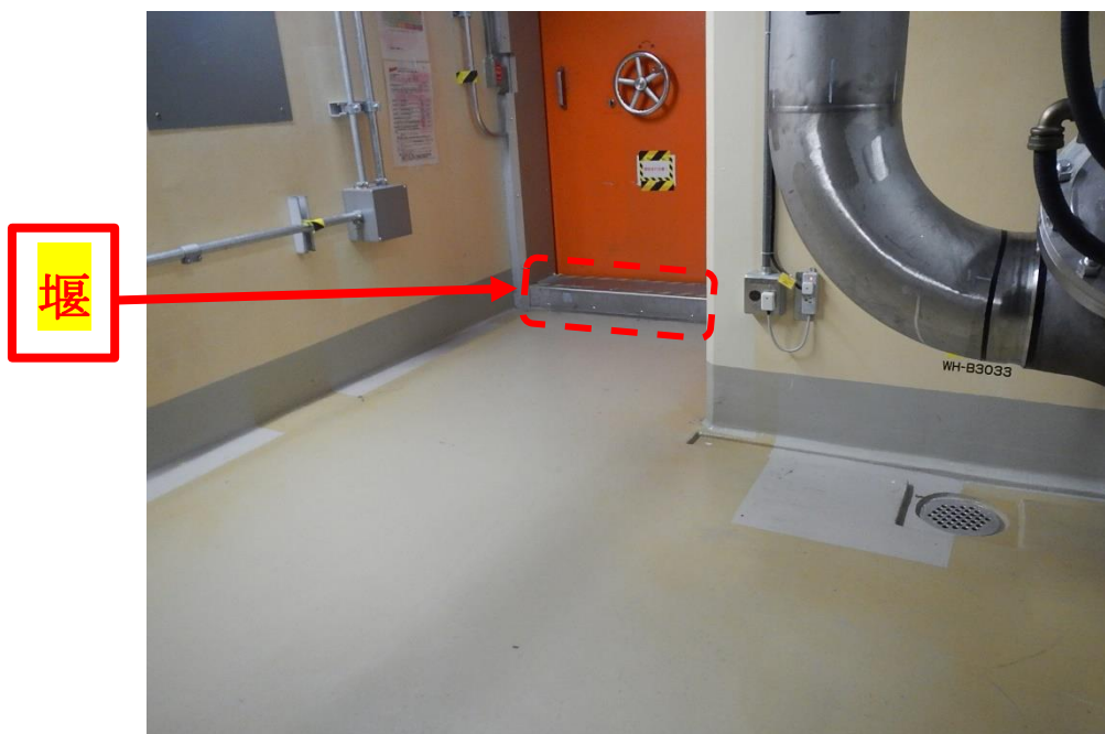
図 4-1 漏えい油の拡大の防止対策の例
