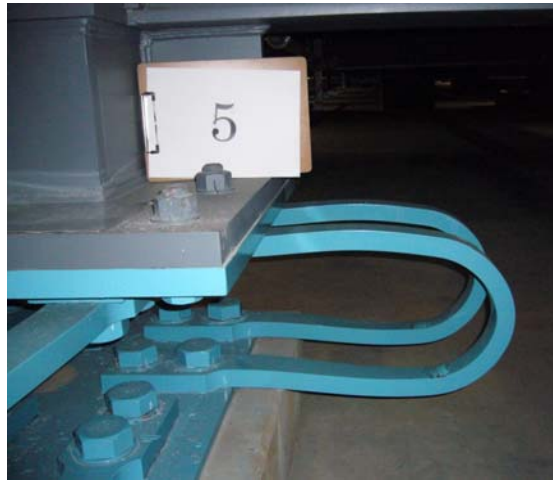
地震後の鋼材ダンパー
