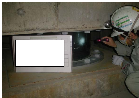
外観確認（外傷有無、錆等）
