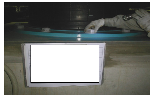
ボルト緩み有無の確認
