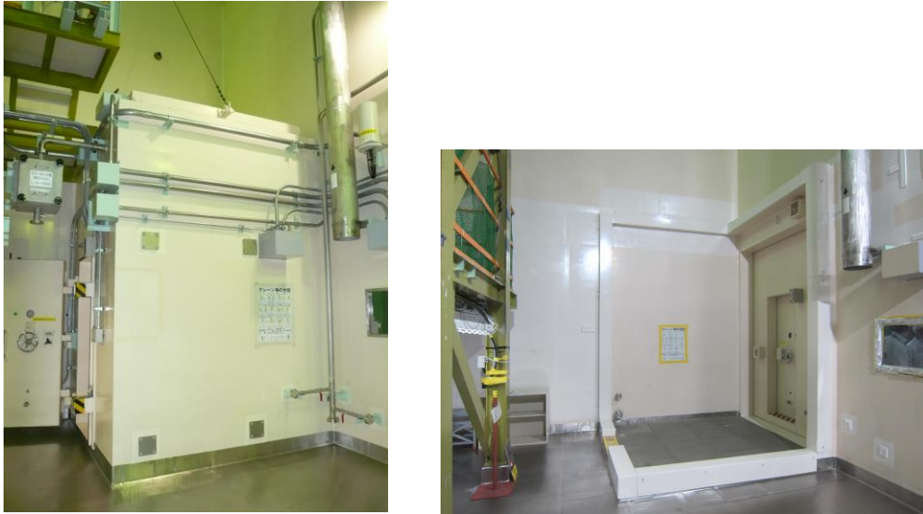
図 6.1-1 炉室(S)エアロック室撤去前及び撤去後
