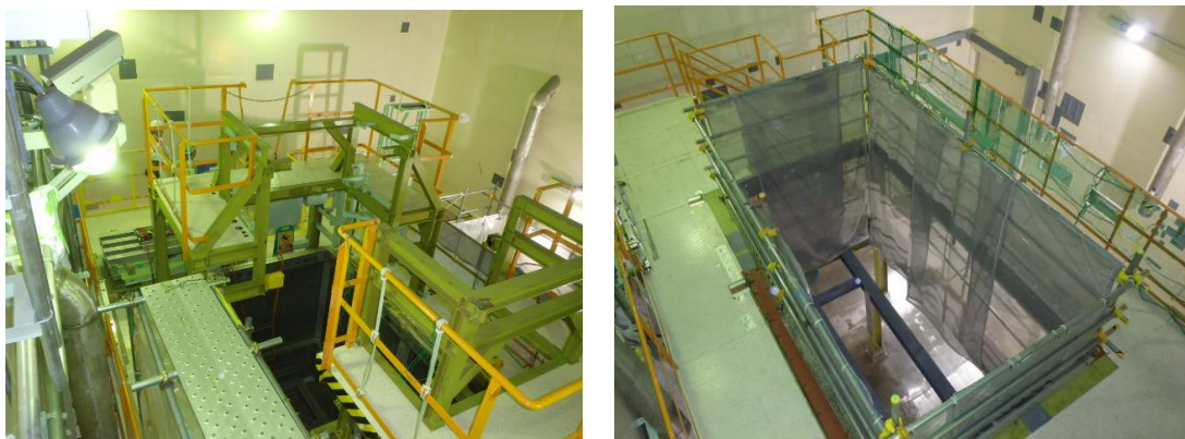
図 6.1-3 実験架台（天板含む）撤去前及び撤去後
