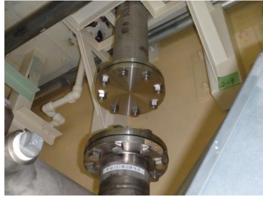
図 6.1-4 炉室(S)換気空調設備系統分離前及び分離後
