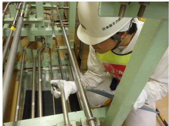
图 6.1-11 溶接検査 (非破壊検査)
