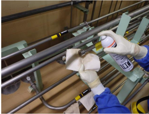
图 6.1-9 耐压漏えい検査
