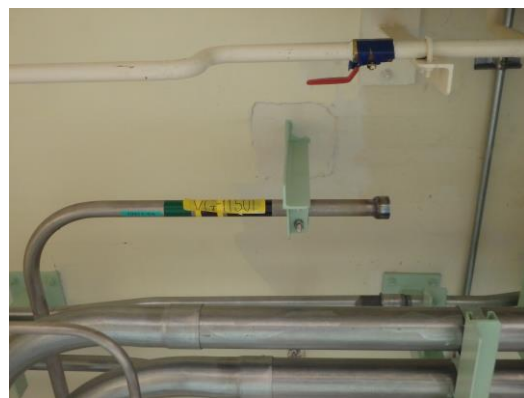
図 6.1-5 槽ベント設備 A 系統分離前及び分離後
