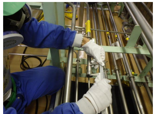
图 6.1-10 溶接検査 (開先検査)
