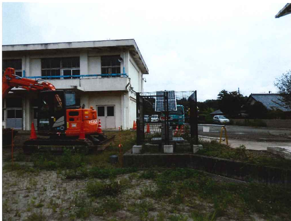
図 2-9-2-9(1) 撤去前のモニタリングポスト (檜葉北小学校 (檜葉町) : 平成 29 年 9 月 7 日撮影)
