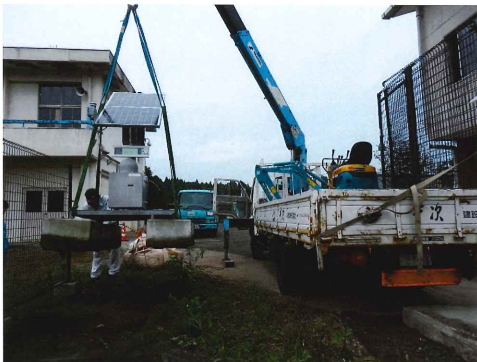
図 2-9-2-9(2) 撤去作業の様子 (檜葉北小学校 (檜葉町) : 平成 29 年 9 月 7 日撮影)
