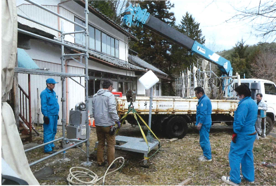
図 2-10-8(2) 撤去作業の様子 (葛尾村柏原地区(葛尾村): 2019年3月26日撮影)
