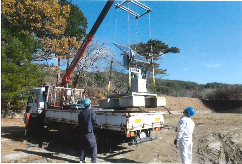
図 2-10-10(2) 撤去作業の様子 (長泥コミュニティーセンター (飯館村) : 2019年11月26日撮影)
