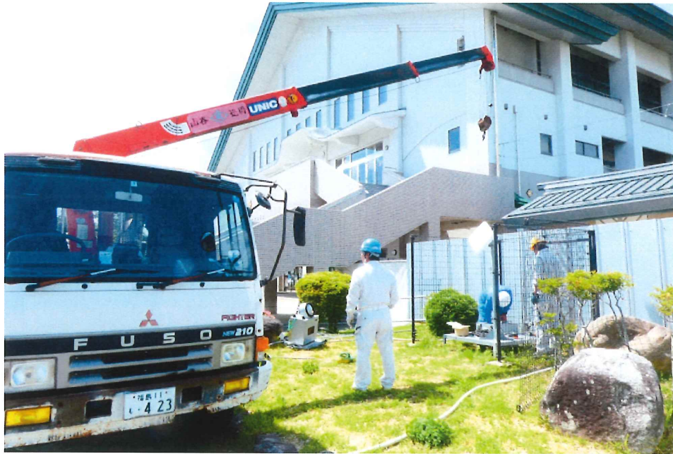
図 2-10-9(2) 移設作業の様子 (スポーツアリーナそうま南東側 (相馬市) : 2019年6月18日撮影)
