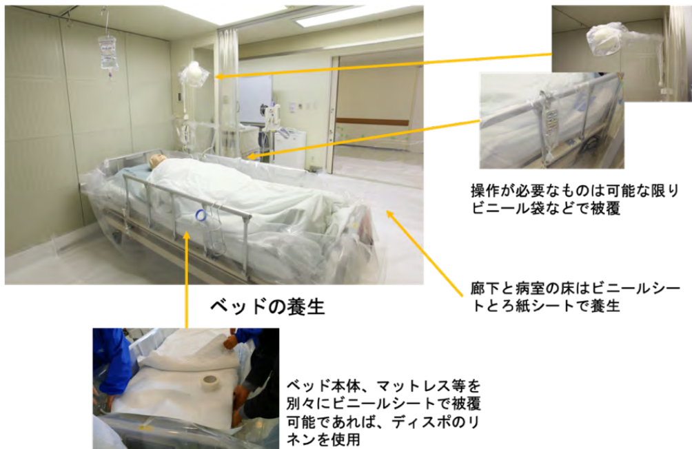
図4 病室の養生（例）
