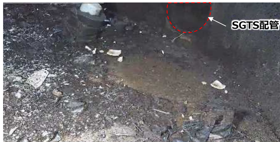
写真：SGTS配管状況(5/20雨天時)
