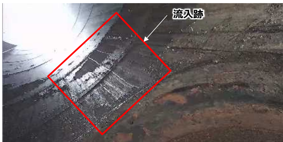
写真：排気筒内面状況(5/20雨天時)
